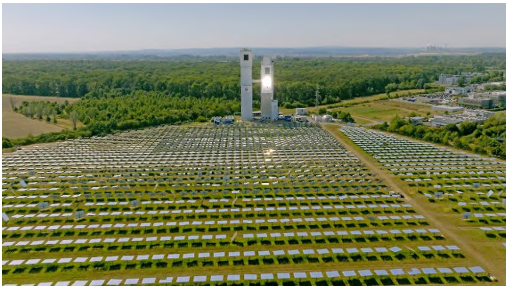
Abb. 1 Luftaufnahme des Solarturms und des Spiegelfeldes des DLR, Jülich. Das Spiegelfeld bündelt die Sonnenstrahlung auf den Solarturm und heizt den Solarreceiver auf.
