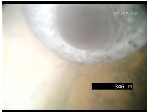
Abb. 3 Blick in einen frisch gebohrten Seitenarm in 346 Meter. Die Mikro-Bohrturbine hat das Granitgestein sauber ausgefräst.
